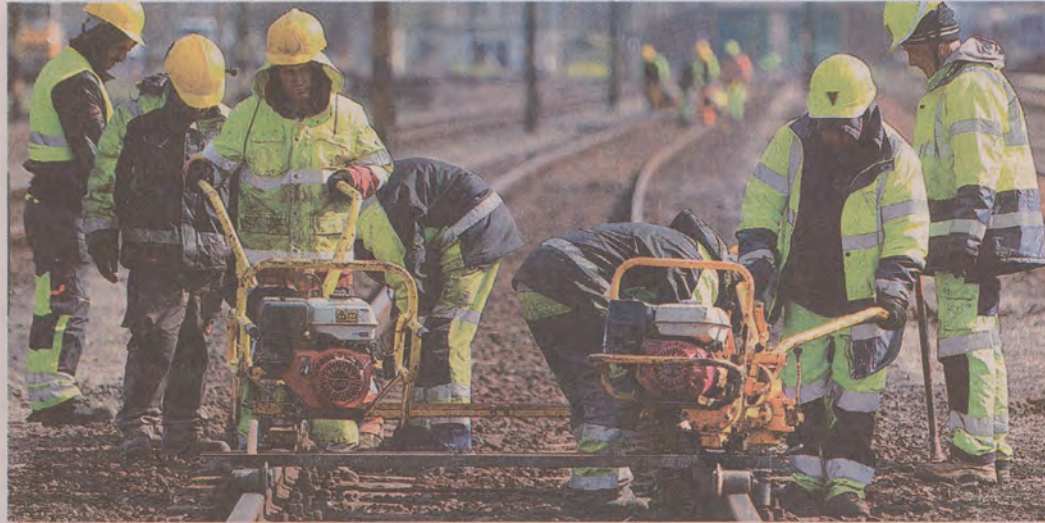
Kiskunhalason jelenleg a síneket és a talpfákat bontják el munkagépekkel
