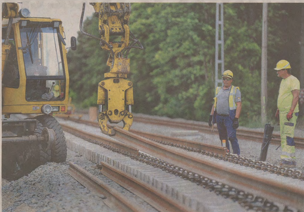
Már az új vasúti síneket fektetik a szakemberek Kiskunhalasánál
