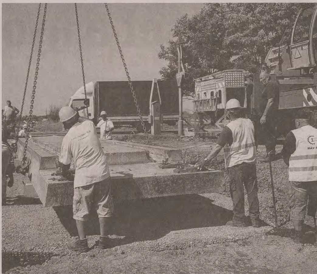
Beemelték az 53-as főút és a 154-es vasútvonal kereszteződésében a betonelemet
