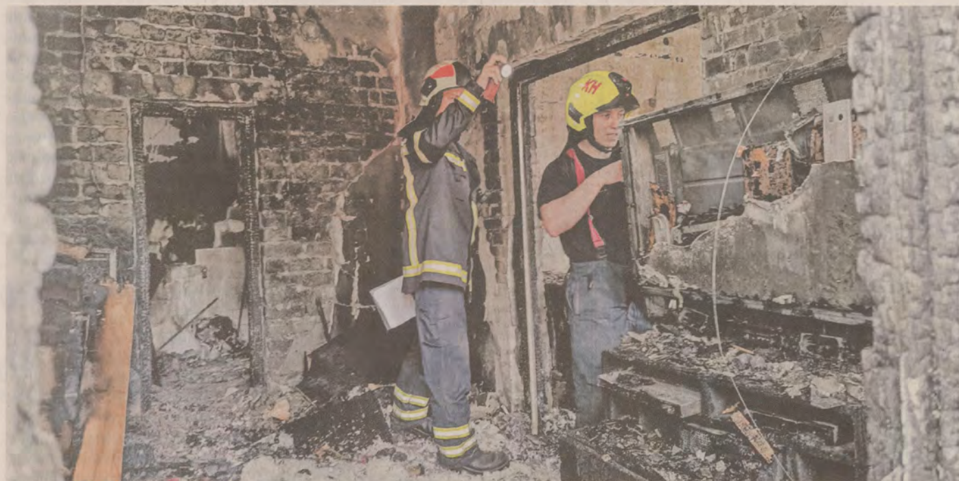
A Fejérföld utcai épület a robbanás után pillanatok alatt lángba borult
