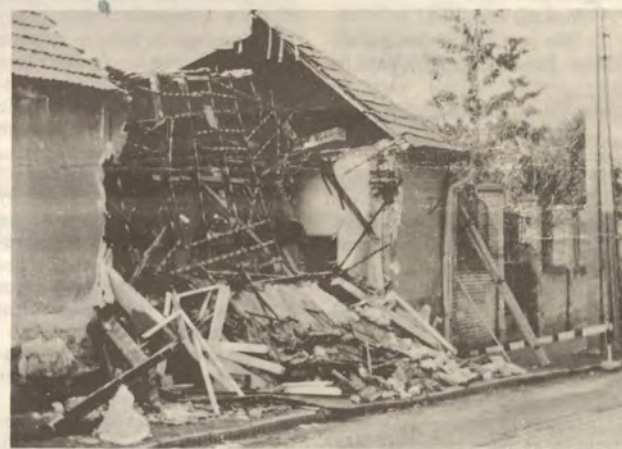
Csőtörés okozta a volt Sütőipari épület beomlása.
