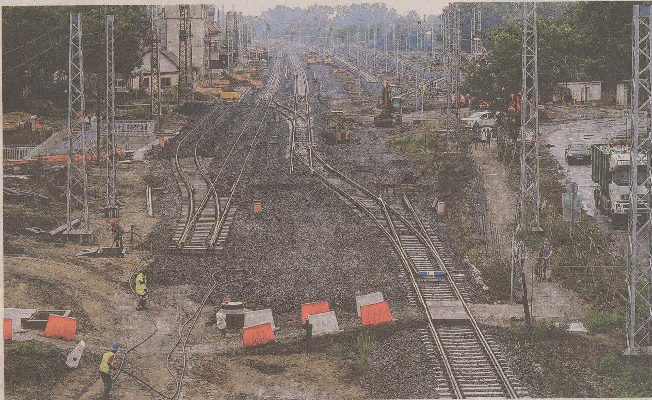
Felülnézetből már jól látható az új kiskunhalasi vasútállomás formája
