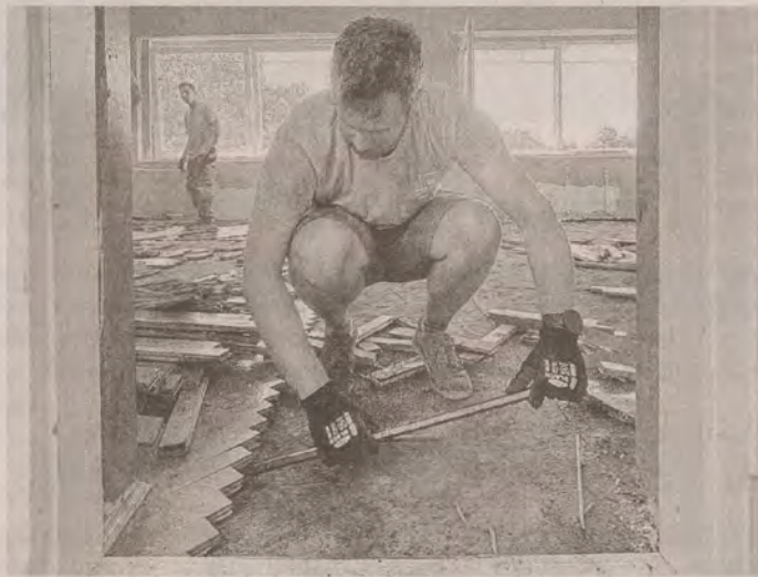
A felújítást a cég kivitelezésben részt vevő dolgozói végzik
