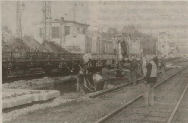
Nagy erővel folyik a 3. vágány építése
